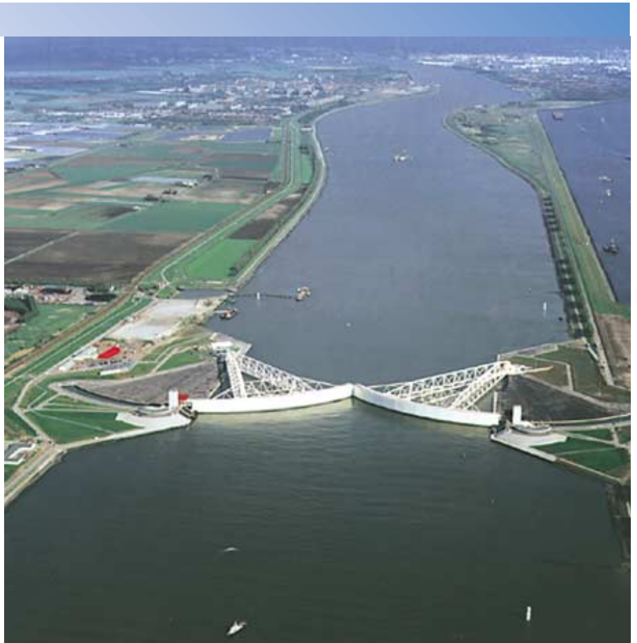
Stormvloedkering Nieuwe Waterweg (Rijkswaterstaat)
