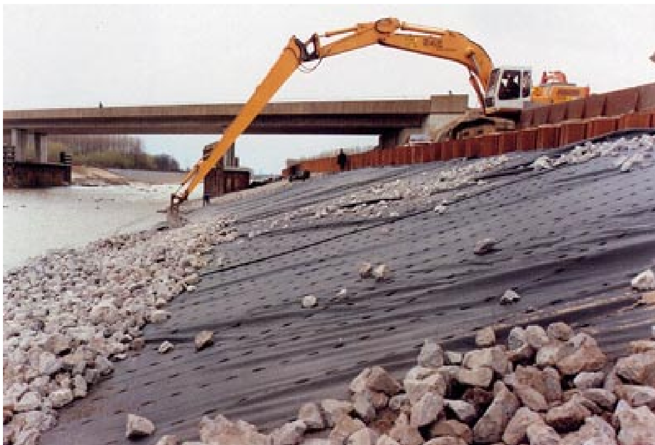
Aanbrengen van breuksteen op geotextiel
