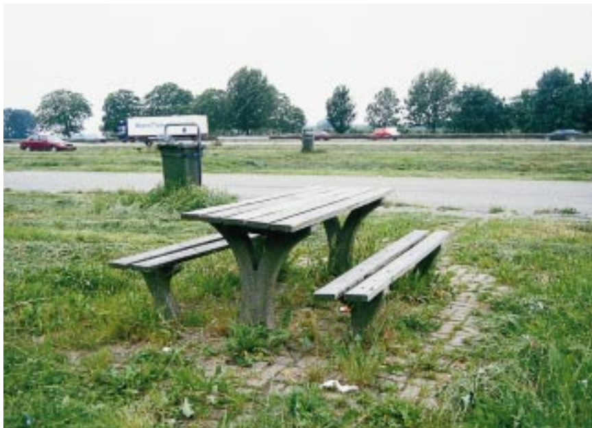
Een onderplaat uit een stuk scheelt in het onderhoud.
