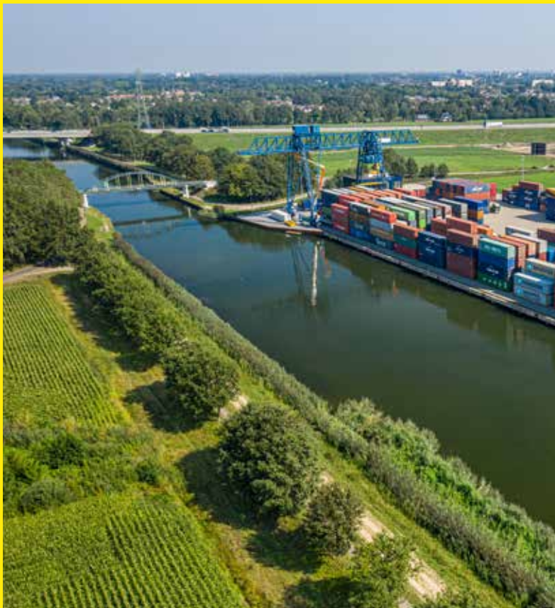
Op het perceel tegenover de XL-kade bij Almelo wordt een zwaaiком aangelegd zodat schepen hier kunnen keren.
