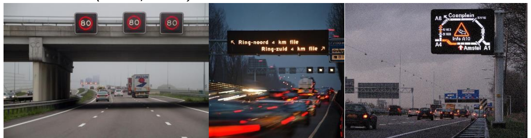
Figuur 5.1: Wegkantinformatiesystemen: matrixborden (links), dynamisch informatiepaneel (DRIP's, midden) en grafisch informatiepaneel (GRIP's, rechts)
