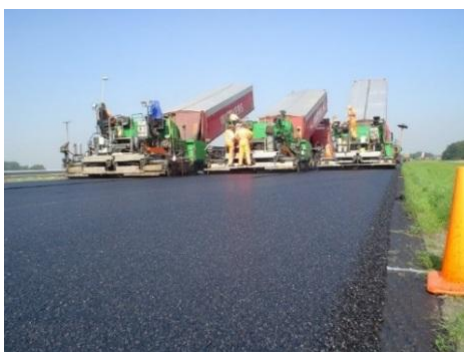
Afbeelding 1. Aanleg proefvak Dubofalt
