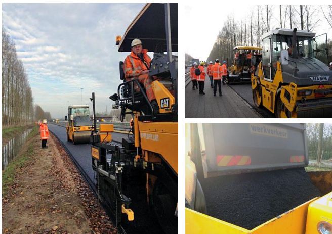
Toepassing Greenway LE in de ITC Pilotvakken op de A2 bij Boxtel
