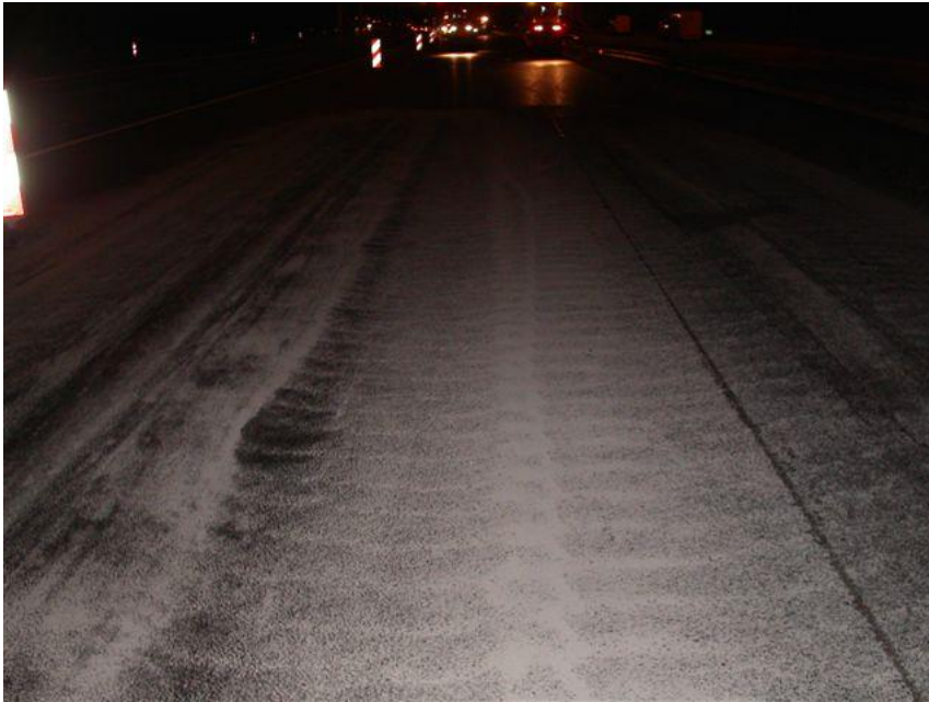
Figuur 1: Afstrooien van proefvak 76Ga.
