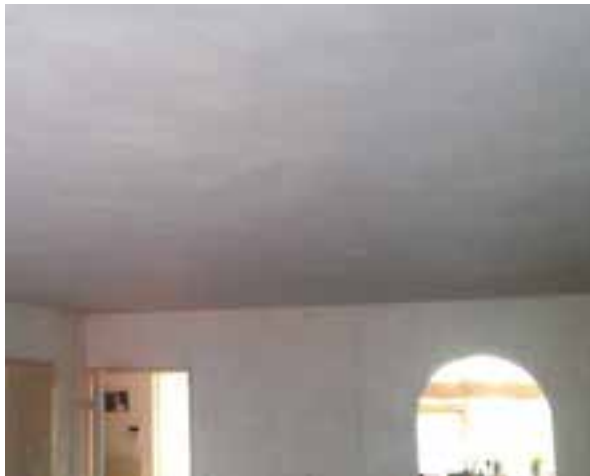
Voorbeeld van schuurwerk
