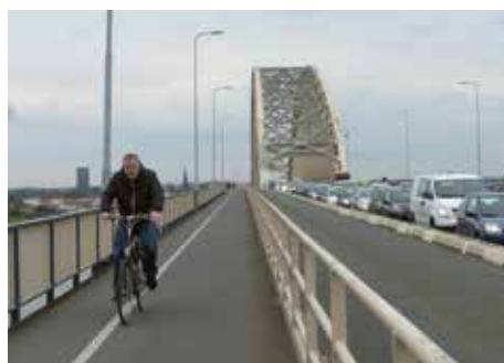
Huidige situatie: busbaan en gecombineerd fiets- en voetpad aan de westzijde van de brug.
