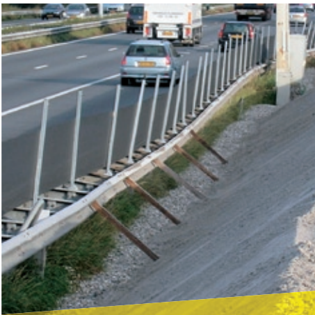
Een met palen gestutte geleiderail om scheefstand tegen te gaan
