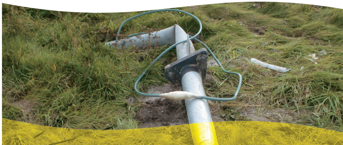
Botsveilige lichtmast in te slappe of niet verdichte grond na aanrijding
