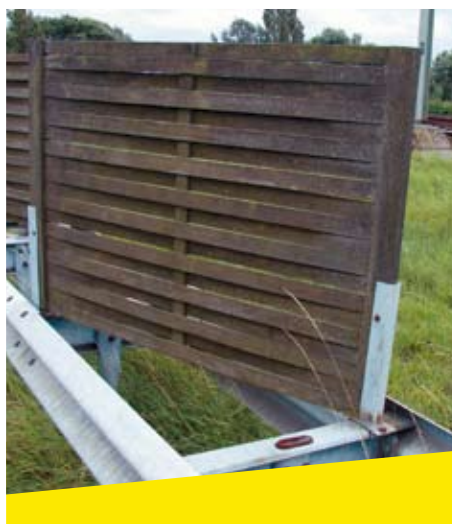
Toepasbaar Azobé anti-verblindingscherm op de geleiderail
