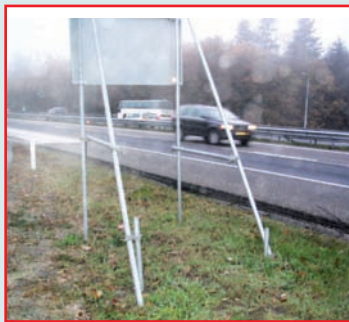
constructie met steigerpijpen
