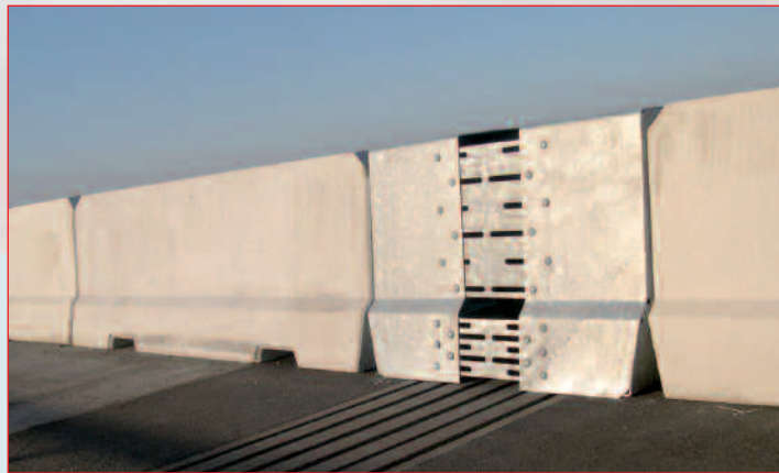
Een stalen dilatatie- (schuif)constructie
