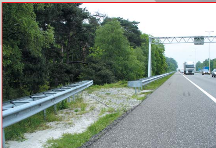
A12, Arnhem – Utrecht, ter hoogte van Maarsbergen. Een veilige doorsteek van de geleiderail.
