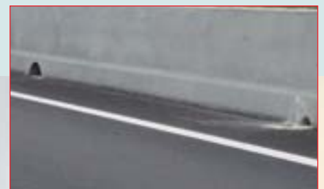
Stepbarrier met slipformpaver
