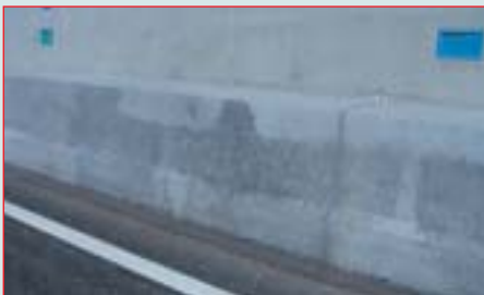
Halve stepbarrier gemaakt met Slipformpaver
