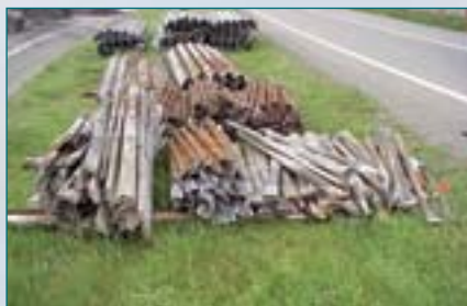
Links oude onderdelen, rechts gerenoveerde onderdelen: niet van nieuw te onderscheiden.
