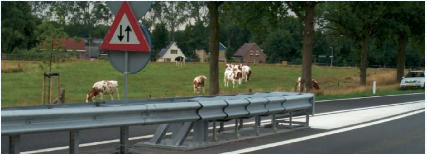
De standaard symmetrische RIMOB P110-5S. Foto: Rijkswaterstaat.
