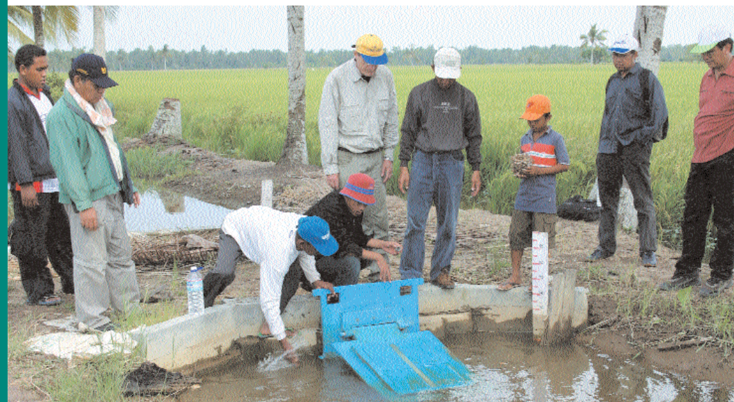
Een flapgate in een kanaal in Indonesië. De flapgates kunnen eenvoudig worden verplaatst, zodat de boeren naar eigen wens water kunnen inlaten of laten wegstromen.
