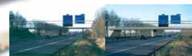
Viaduct huidige situatie
