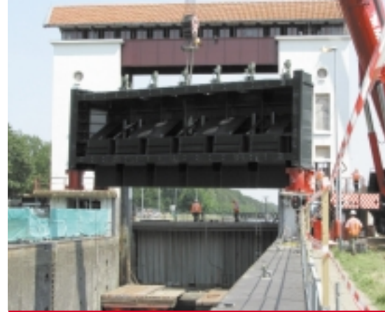
Een nieuwe deur voor de sluis Eefde.
