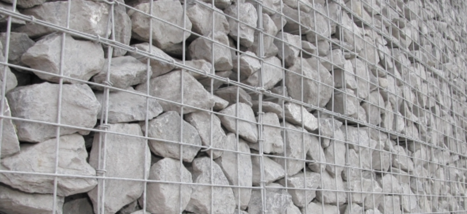
De 'buitenbekleding' van het nieuwe bedieningsgebouw/installatiehuis.
