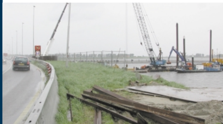
Het doorlaatmiddel bestaat uit twee betonnen kokers van elk 82,5 meter lang en 5,5 meter breed. Ze liggen verscholen in het zand en de klei.
