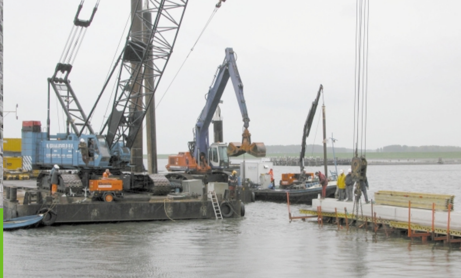
Nabij het doorlaatmiddel zijn de geleidedammen nog in aanbouw.
