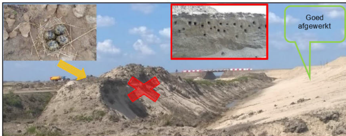
Figuur 7 Voorbeeld slecht en goed afgewerkte depots
