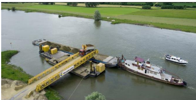
Figuur 8 Voorbeeld laadbrug waarin zand in beunbakken gelost wordt
