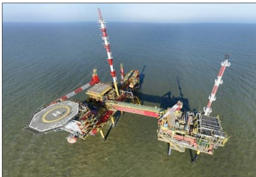
Figuur 2.2: Platform(complex) AWG.
