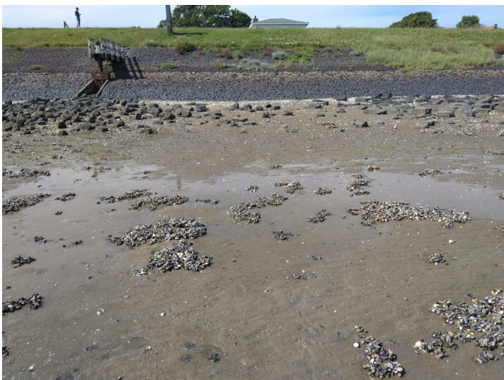
Foto vanaf het wad richting de dijk
