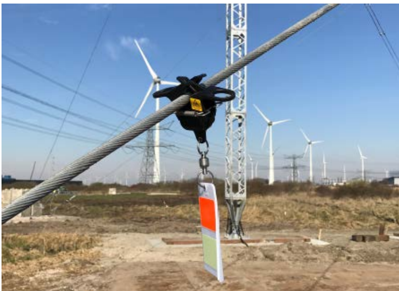
Foto van een firefly opgehangen in een tuidraad.
