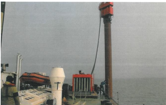
Figuur 5: intrillen van een paalanker
