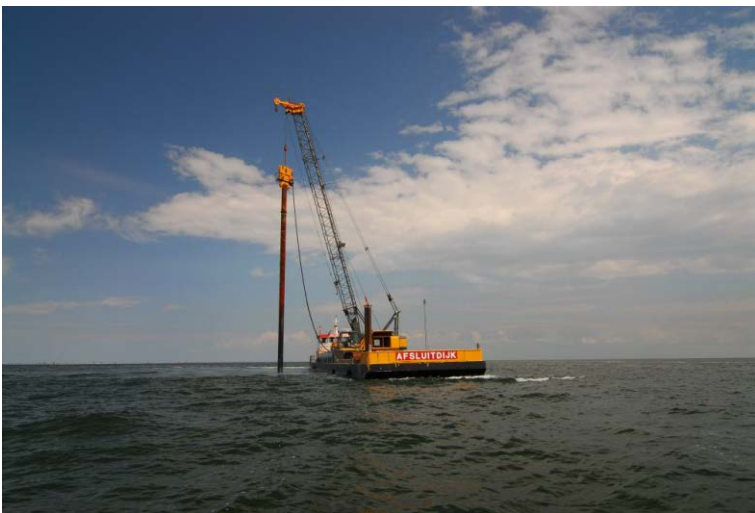
Fig. 6. Werkschip "Afsluitdijk" fa. Klein Wieringen tijdens het positioneren van het 20 m-paalanker (uit de Haan & Burggraaf 2012).
