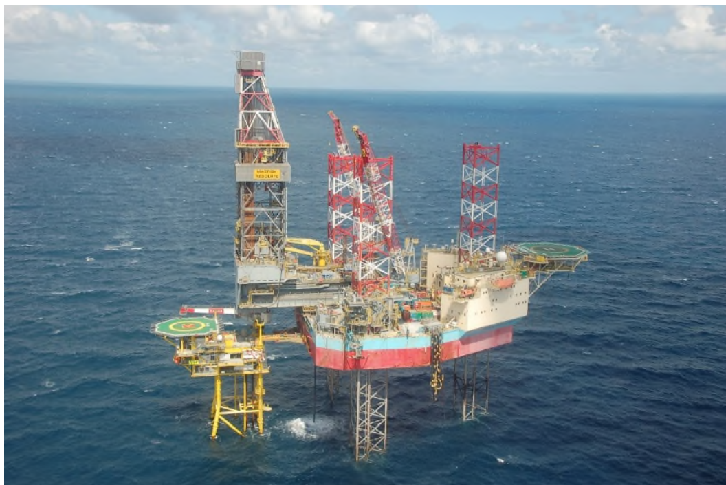
Figuur 3.2: Boorinstallatie (rechts) tijdens eerdere boring bij platform A18 (links), deels vergelijkbaar met platform A12-CPP.
