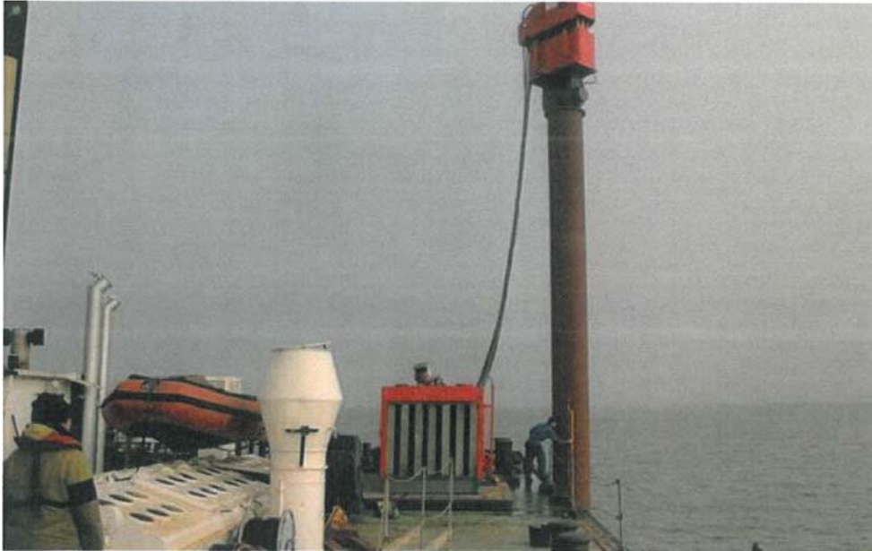
Figuur 16: intrillen van een paalanker
