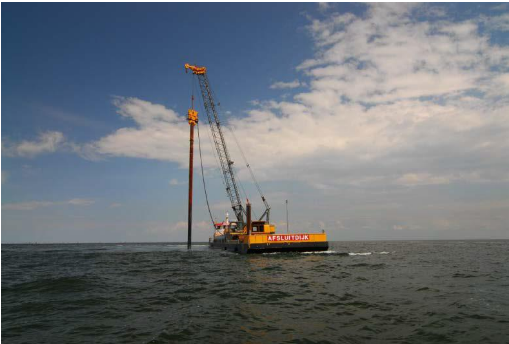
Figuur 5. Werkschip "Afsluitdijk" fa. Klein Wieringen tijdens het positioneren van het 20 m-paalanker (uit de Haan & Burggraaf 2012).
