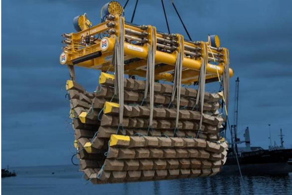
Afbeelding 2 Standaard blokkenmatten voor offshore gebruik in een hijsjuk.
